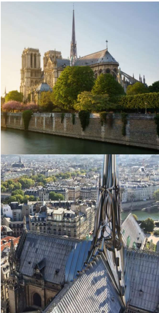
Figura 5. Propuesta para Nôtre-Dame de Paris a) Vista desde el Sena; b) Nueva aguja incorporando las esculturas originales (Gonzalez-Longo & Milanov, 2019).
