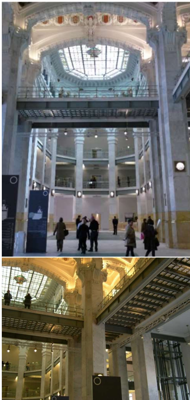
Figura 4. Palacio Cibeles, Madrid a) atrio; b) detalle de la estructura. Fuente: autora.
