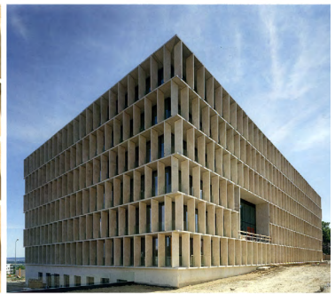
1000-bed hospital, kortijk: baumschlager + eberle
